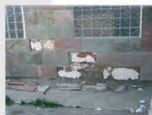
Deficiencias en la colocación
