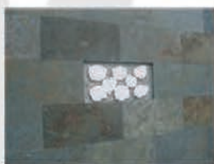
Deficiencias en la colocación
